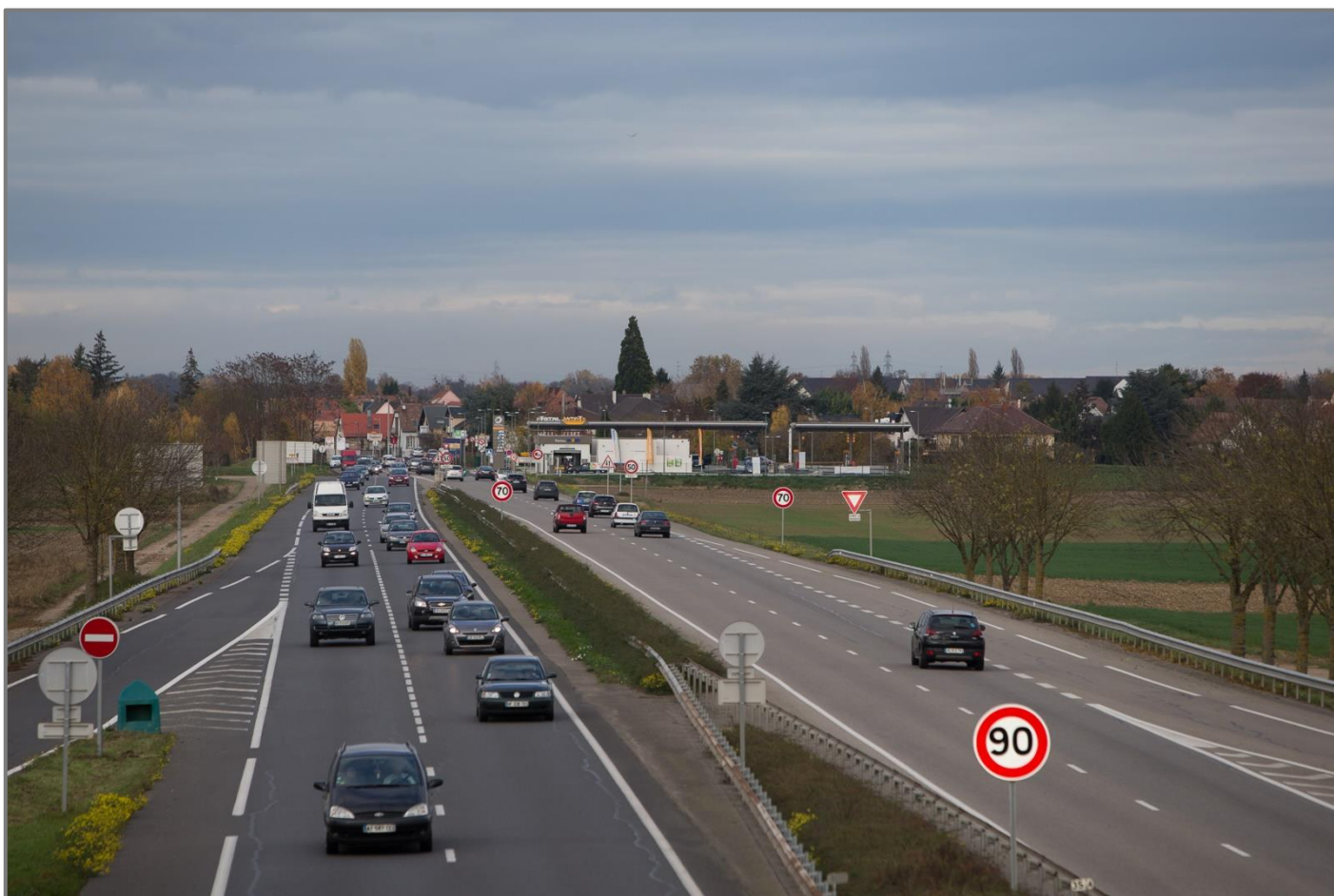
La RD1083 à Ichtratzheim-Faubourg avant les travaux d'aménagement dans la partie en agglomération
