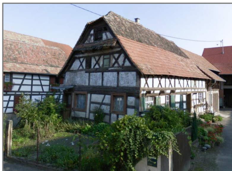
Ci-dessus : habitation disparue au niveau de l'angle de la rue du château avec la rue de l'étang Ci-contre : grange modifiée à côté du presbytère
