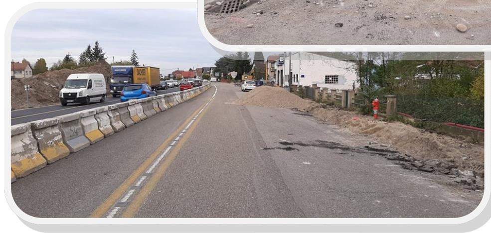
**Mi-novembre** : travaux de mise en place des différents réseaux nécessaires et création du côté EST du giratoire. Les travaux sur le bassin d'eaux pluviales se poursuivent en parallèle.
