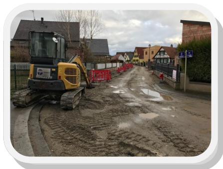
Février 2017 : ouverture partielle des enrobés de la voirie rues de la Scheer et des Vergers pour la mise en œuvre des nouveaux réseaux d'éclairage public
